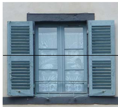
Les menuiseries doivent être teintées en divers gris pour se fondre dans le ton de la façade
