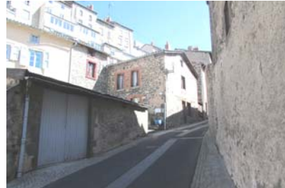
Garage avant le n° 34 rue des planchettes
