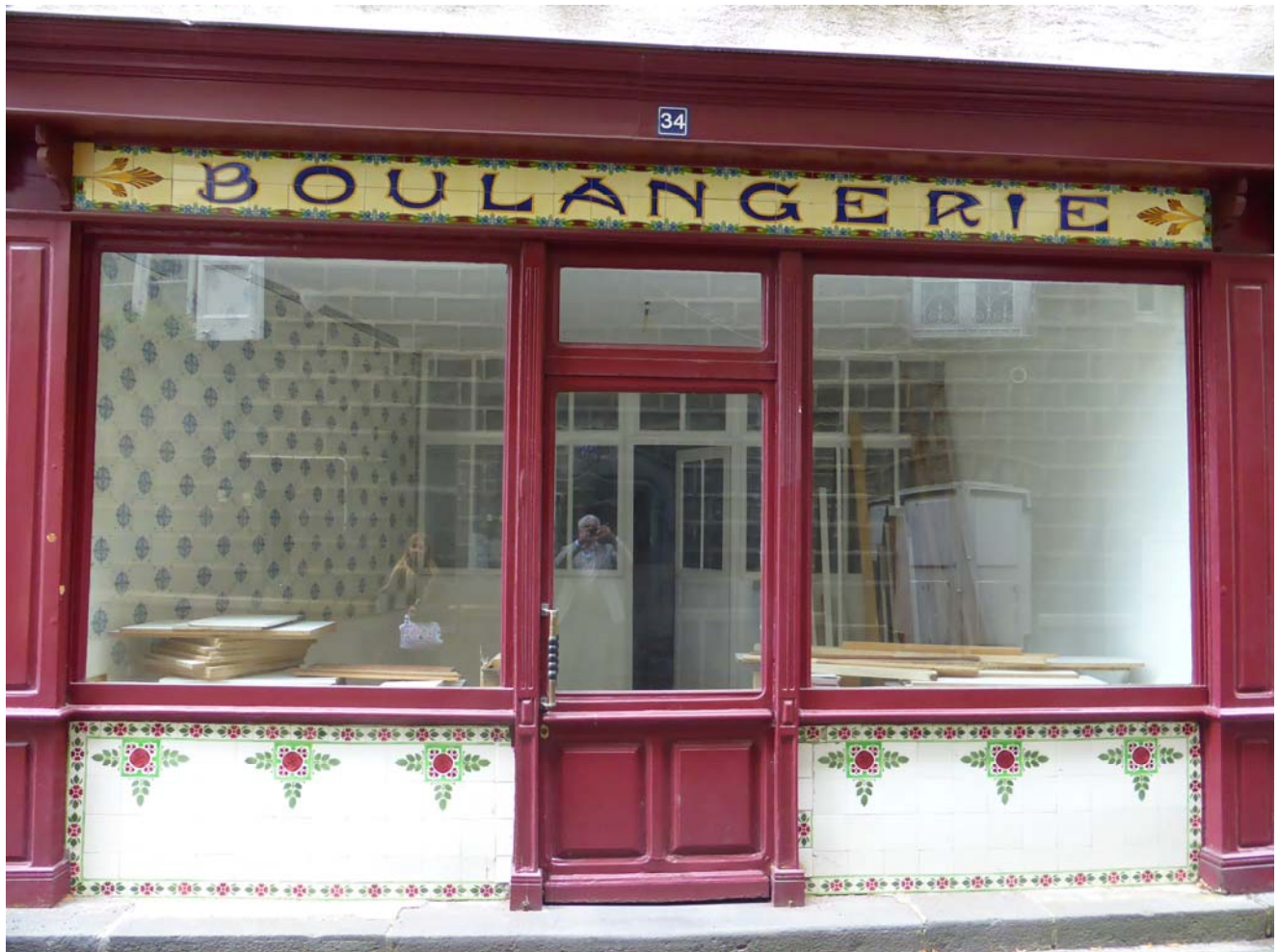
La pose d'une devanture en bois permet l'apport d'un décor et une coloration de la façade commerciale.
