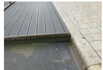
Lorsqu'on doit faire un platelage temporaire de mise à niveau d'un trottoir, celui-ci ne doit pas excéder la hauteur du trottoir ; celui-ci peut aussi être réalisé en tôle d'acier de ton gris.
