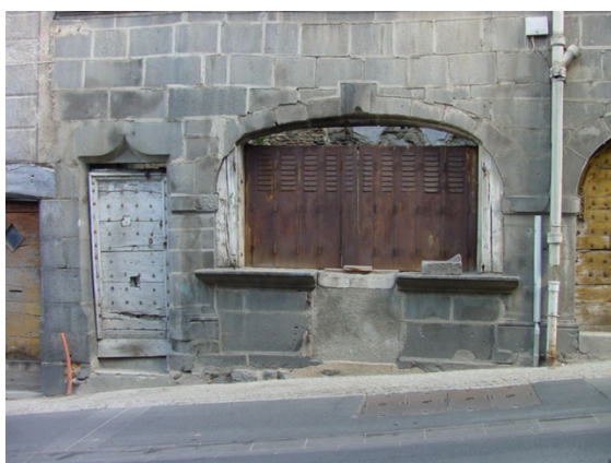
D'anciennes échoppes ou ouvroirs sont appropriées aux devantures commerciales ; en général la fermeture se fait par un volet en bois.
