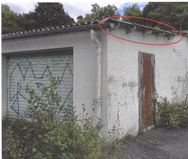
Empannage bois du volume rapporté Sud-Ouest
