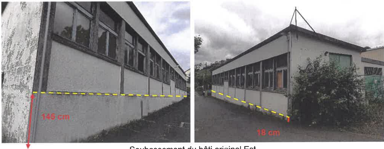
Soubassement du bâti originel Est
